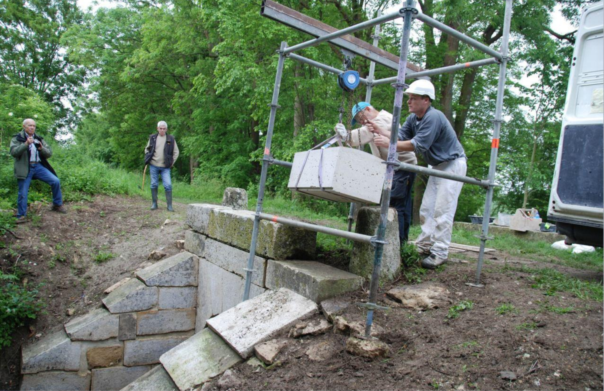
Pose de la pierre taillée par les Ateliers de Coubertin à Saint-Rémy-les-Chevreuse
